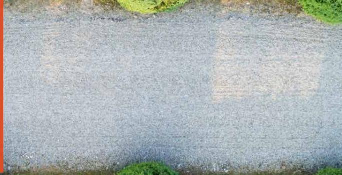
Wassergebundene Decken sind Wegebefestigungen mit Deckschichten aus 100% natürlichen Sand-Splitt-Gemischen, in unterschiedlichen Färbungen.
